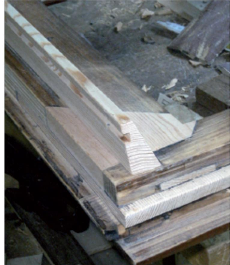
Détail de la reconstruction de l'élément mouluré de l'ouvrant et des nouvelles feuillures dans différentes positions et différentes épaisseurs pour rétablir l'étanchéité d'origine de la connexion entre le meneau et l'imposte. Courtesy Augusto Capovilla S.a.s.
