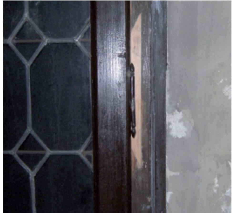
Exemple d'encastrement sur montant en correspondance avec une charnière "fiscia" pour assurer une meilleure tenue et un meilleur mouvement de l'ouvrant.
