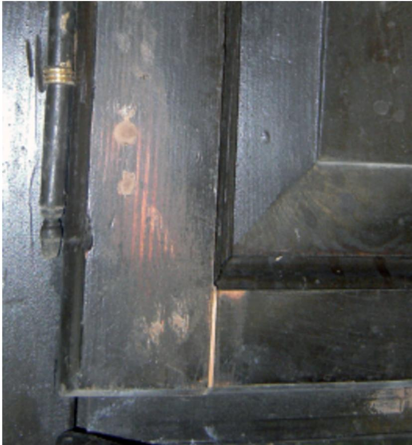
Exemple d'intervention visant à remettre l'ouvrant à l'équerre en insérant une fine cale en bois entre la traverse et l'imposte.
