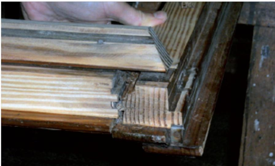
Les figures montrent la détérioration de l'imposte inférieure, où l'infiltration d'eau a provoqué le pourrissement du bois. En particulier, dans la figure supérieure gauche, on peut voir les dommages causés par l'eau infiltrée qui s'est arrêtée dans la rainure pour le logement de la vitre. Avec l'aimable autorisation d'Augusto Capovilla S.a.s.
