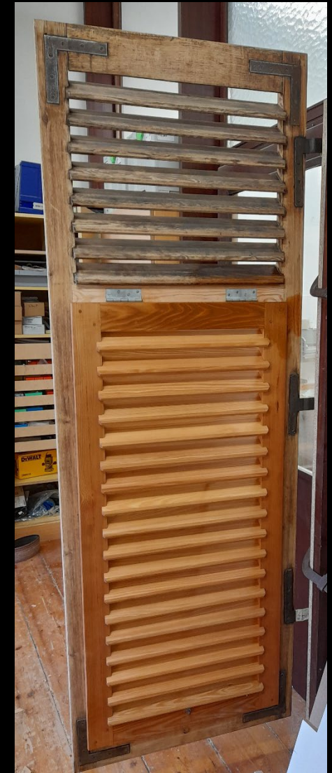
▲ Château d' Eggenberg, adaptation des volets, pose d'une nouvelle partie affichable
